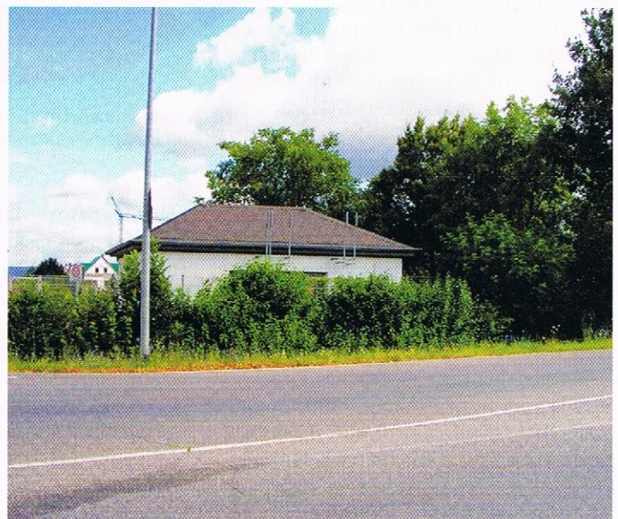
Mess- und Regelanlagen sind häufig dicht am öffentlichen Verkehrsraum angesiedelt. Das hier gezeigte Beispiel liegt zudem an einer viel befahrenen Abzweigung mit neu angeschlossenem Kreisverkehr.
